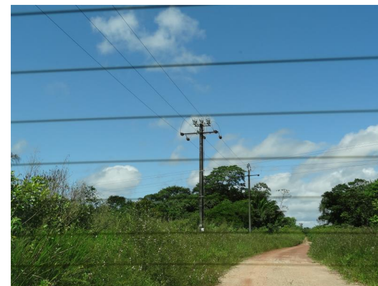
Figure 17 : Vue sur la zone de raccordement (source : VOLTALIA)
