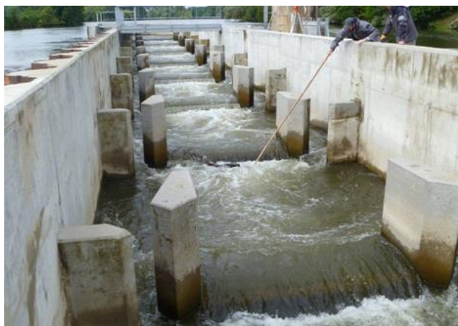
Figure 11 – Exemple de cheminements sur des passe à bassins : les Lorrains à gauche) et le Bazacle (à droite)
