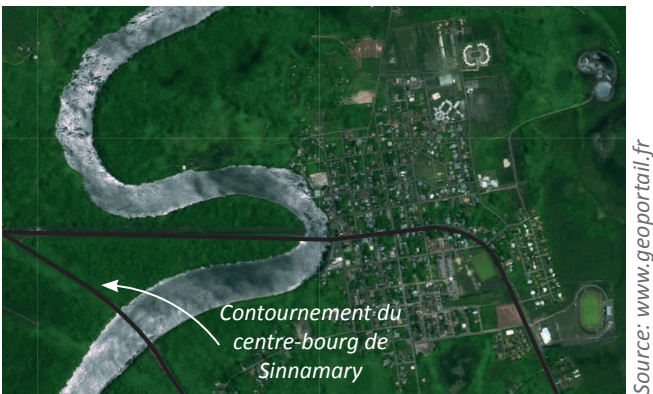
- Vue aérienne du centre-bourg de Sinnamary en 2013 - Source: www.geoportail.fr
