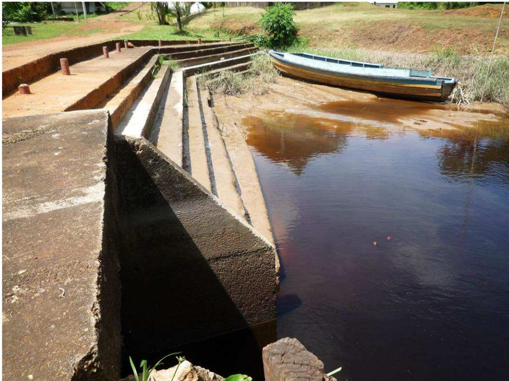
*Figure 8. Vue de la crique canalisée et endiguée au niveau du débarcadère côté bourg (dalot béton au premier plan)*
