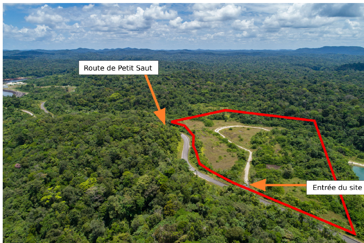
Figure 1: Vue du site actuellement
