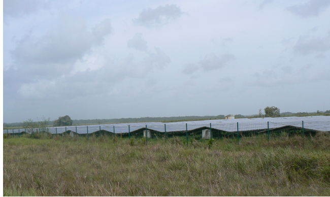
Parc photovoltaïque de la « Savane de Corossy ».
