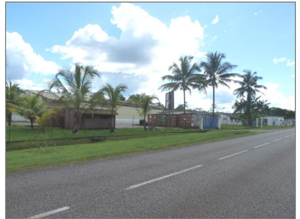
Illustration 28 : Usine de traitement des eaux sur le RN2
