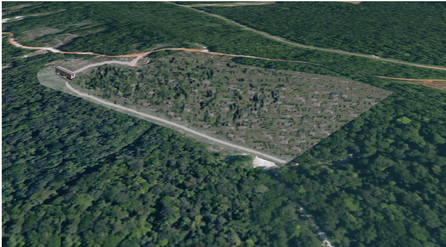
Etat final : Vue côté sud en hauteur
