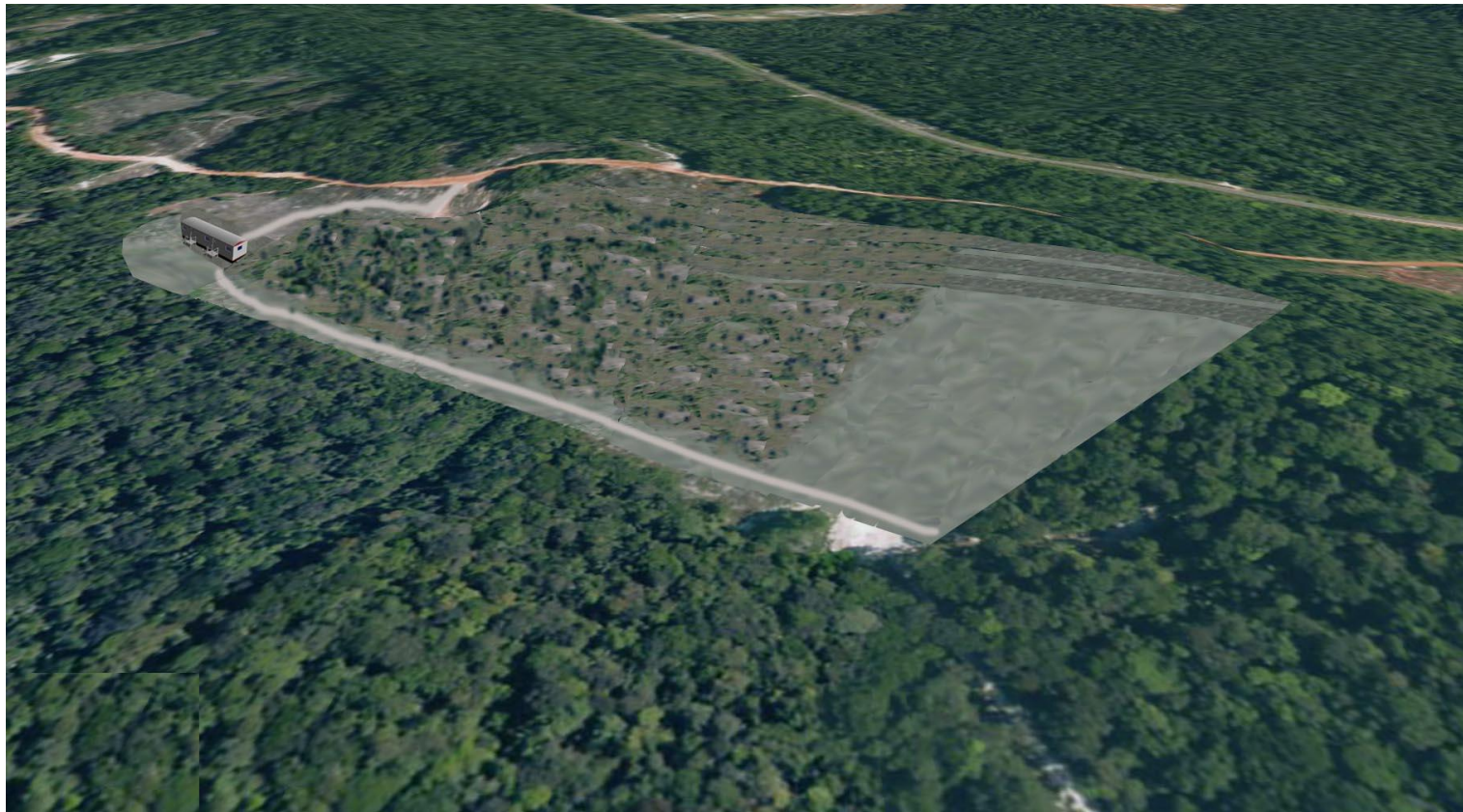
Phase 4 : T0 +20 Vue côté sud en hauteur
