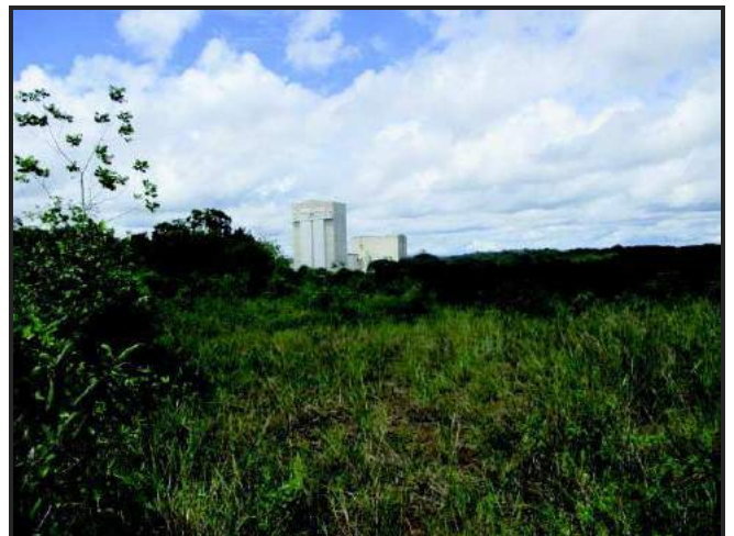
Figure 5 : Photo du BIP depuis la future piste de d'accès du BBP
