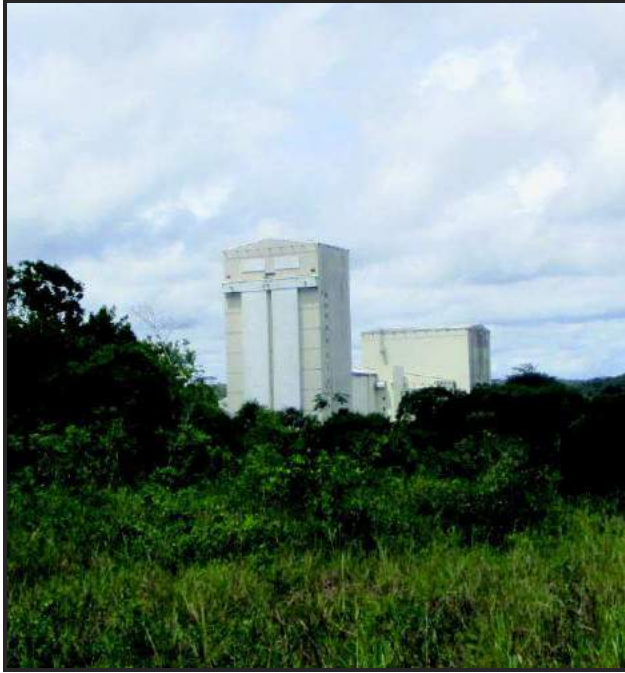
Figure 46 : Vue du BIP depuis la future route d'accès du BBP
