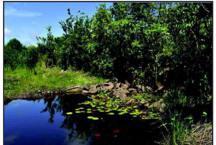
Figure 26 : Buse passant sous le chemin de ronde du CSG au niveau du Pripri de la Karouabo (Hydreco)
