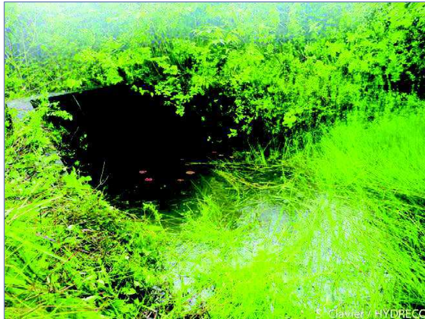
Figure 14 : L'hydromorphologie de la station drain Europropulsion est partiellement artificialisée comme en témoigne la présence de buses
