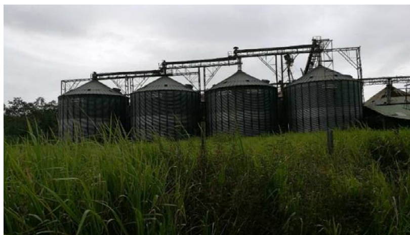
Figure 16 : Vestiges de bâtiments industriels (Source : VOLTALIA)
