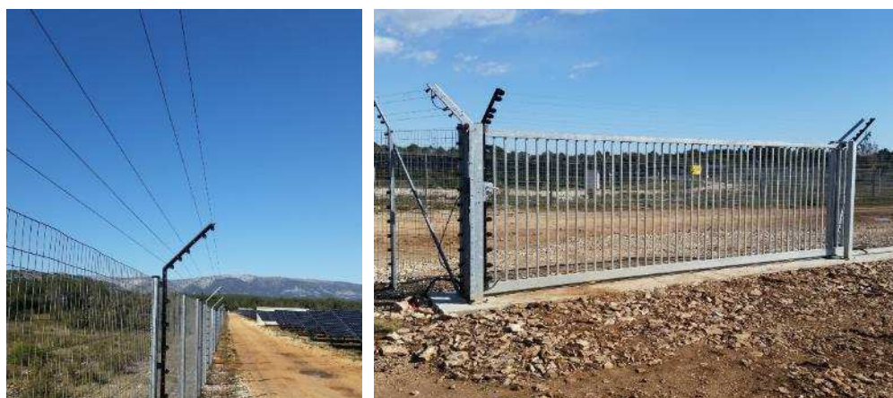
Figure 14 : Exemple de clôture périphérique électrifiée (source : VOLTALIA)
