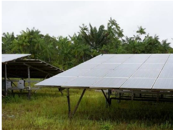
Figure 12 : Exemple de modules et supports envisagés (Source : VOLTALIA)
