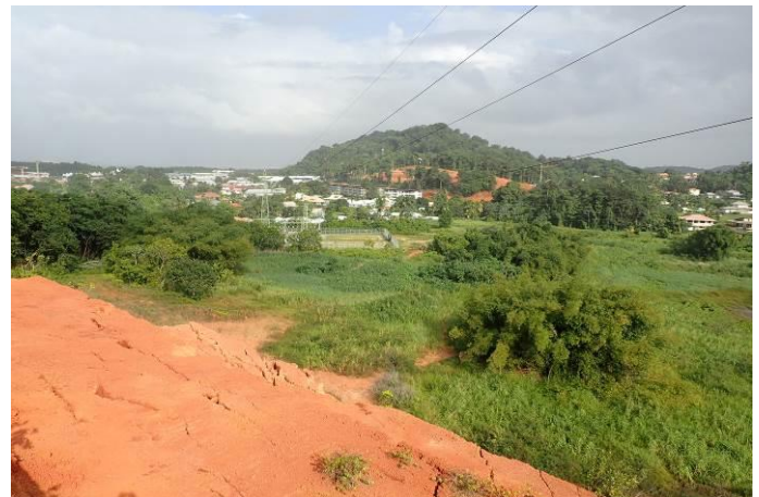
Second redan présentant également des fissures et lézardes avec des débuts de décrochement
