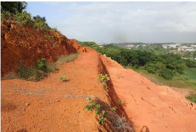
Second redan présentant également des fissures et lézardes avec des débuts de décrochement
