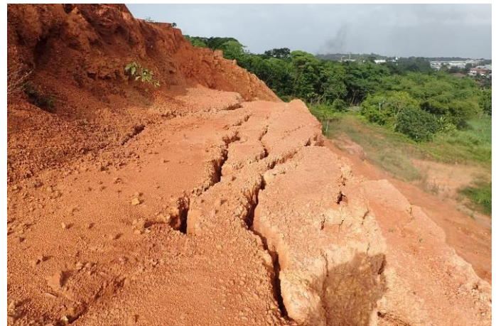
Premier redan présentant d'importantes fissures favorisant l'imprégnation en eau des couches inférieures
