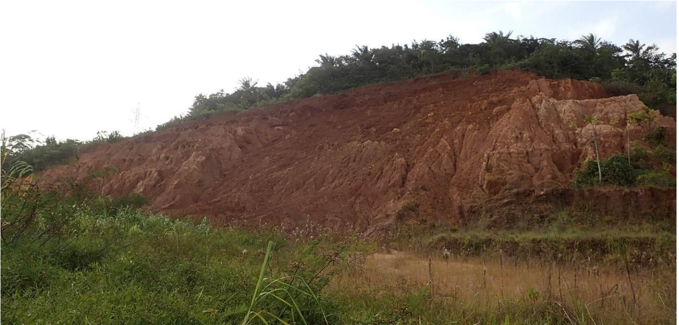
Évolution des glissements depuis l'étude géotechnique G2 AVP
