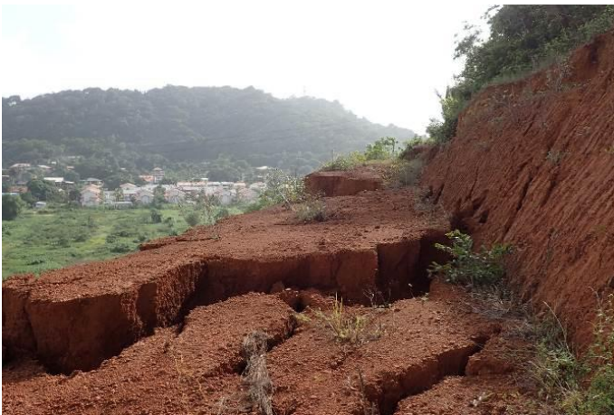
Premier redan présentant d'importantes fissures favorisant l'imprégnation en eau des couches inférieures
