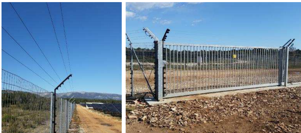
Figure 19 : Exemple de clôture périphérique électrifiée (source : VOLTALIA)
