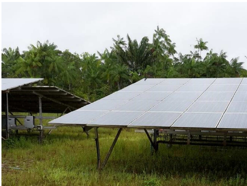
Figure 9 : Exemple de modules et supports envisagés (Source : VOLTALIA)
