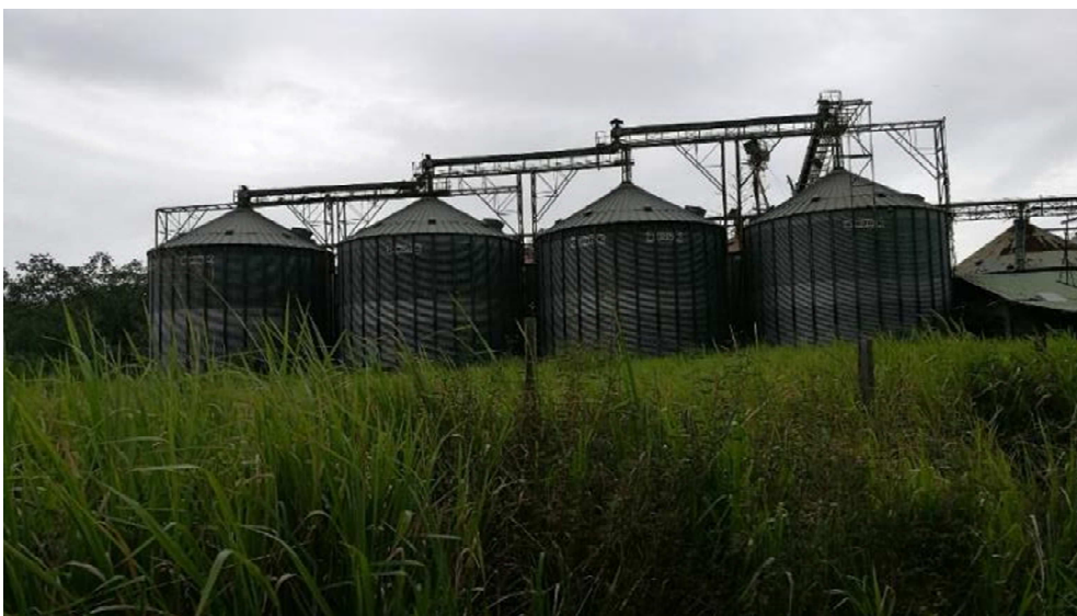
Figure 26 : Vestiges de bâtiments industriels (Source : VOLTALIA)
