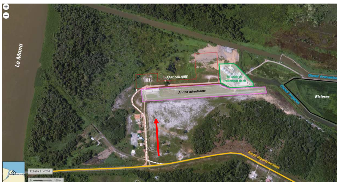
Figure 16 : Accès au site (Source : VOLTALIA)
