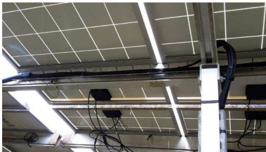
Figure 10 : Exemple de chemins de câbles (Source : VOLTALIA)
