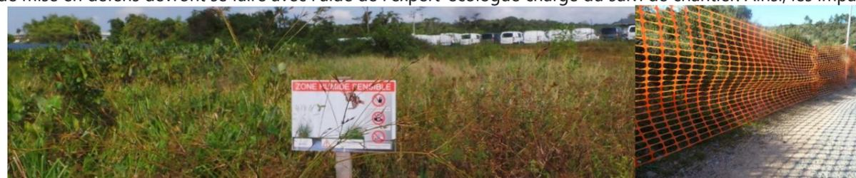
Figure 73 : Exemple de dispositifs de mise en défens : barrière orange de chantier et panneau
