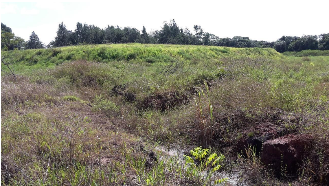
FIGURE 6 : FOSSE BRUT POUR LA COLLECTE DES EAUX DE RUISSELLEMENT DU DOME
