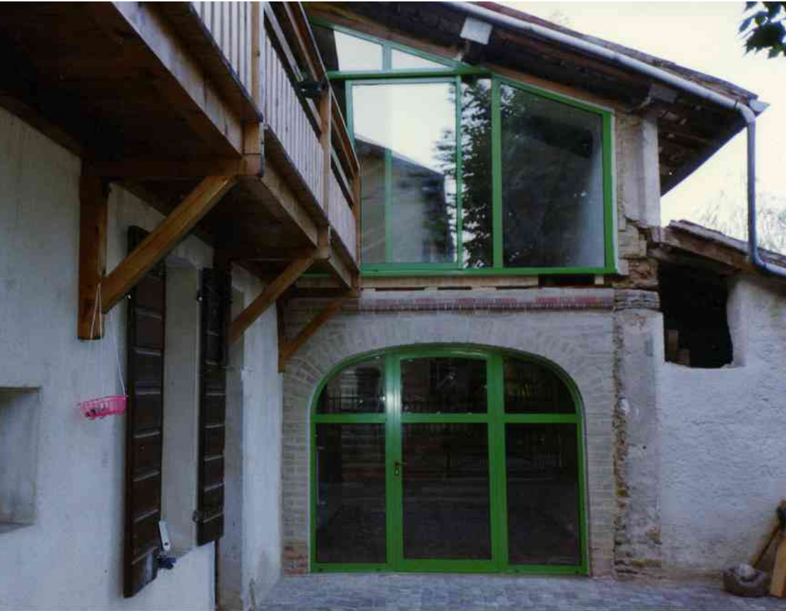
Rénovation maison en pisé
