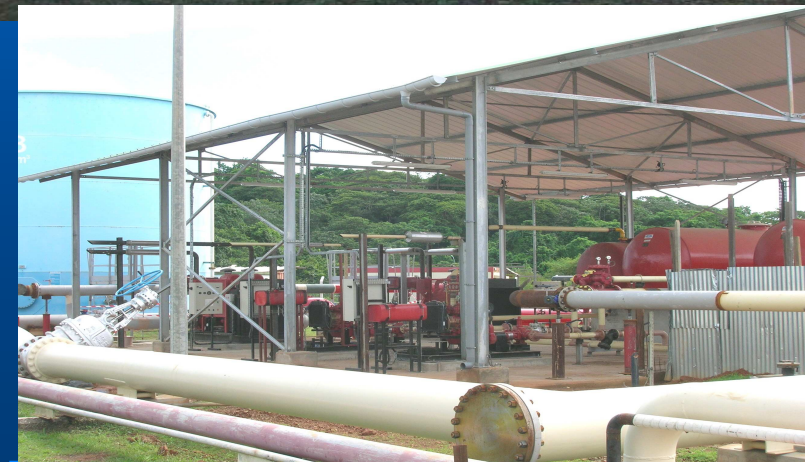
NAPPE DE TUYAUTERIES INCENDIE
