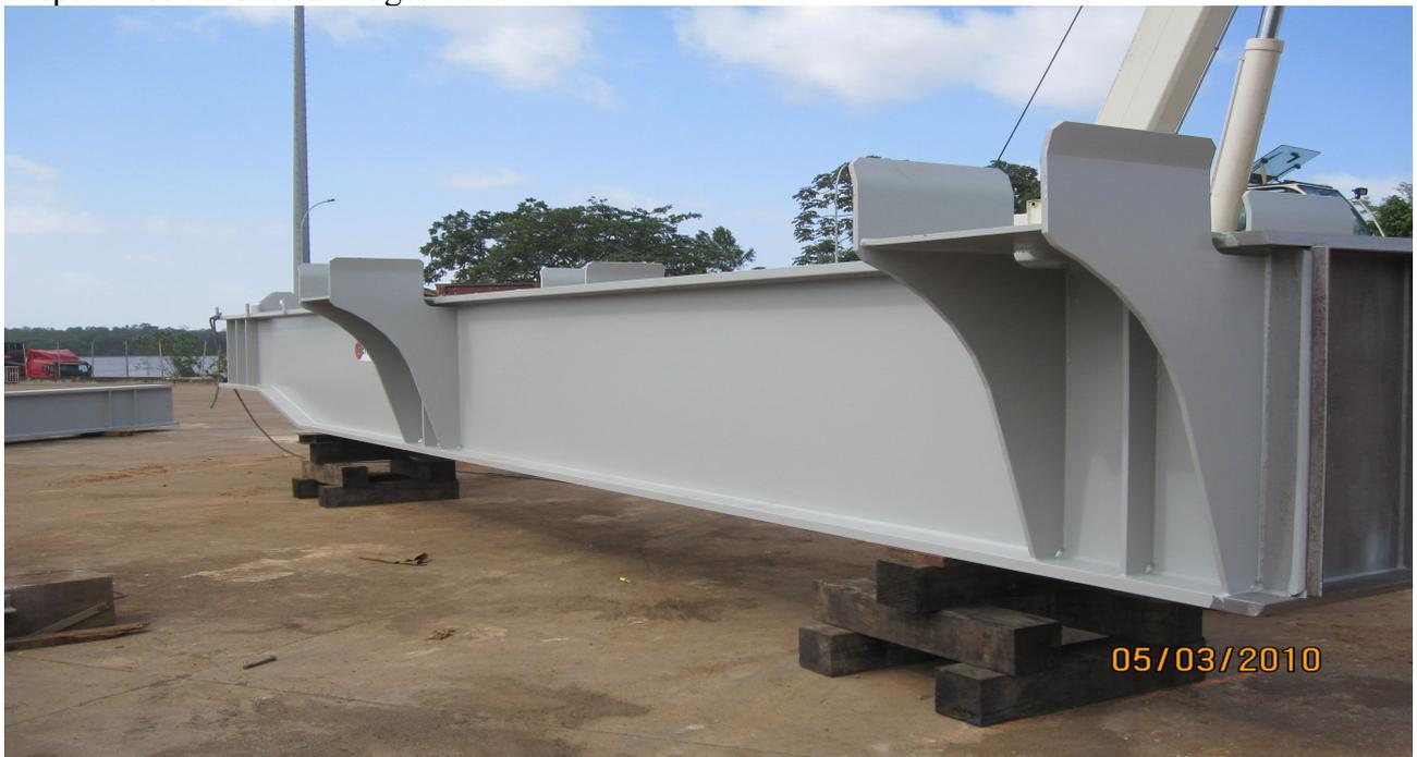
Les poutres transversales sont longues de 8 mètres, haute de 80 centimètres et pèse plus de 6 tonnes. Elles ont été fabriquées elles aussi dans les usines de l'entreprise Berthold et acheminées par le bateau du 2 mars.
