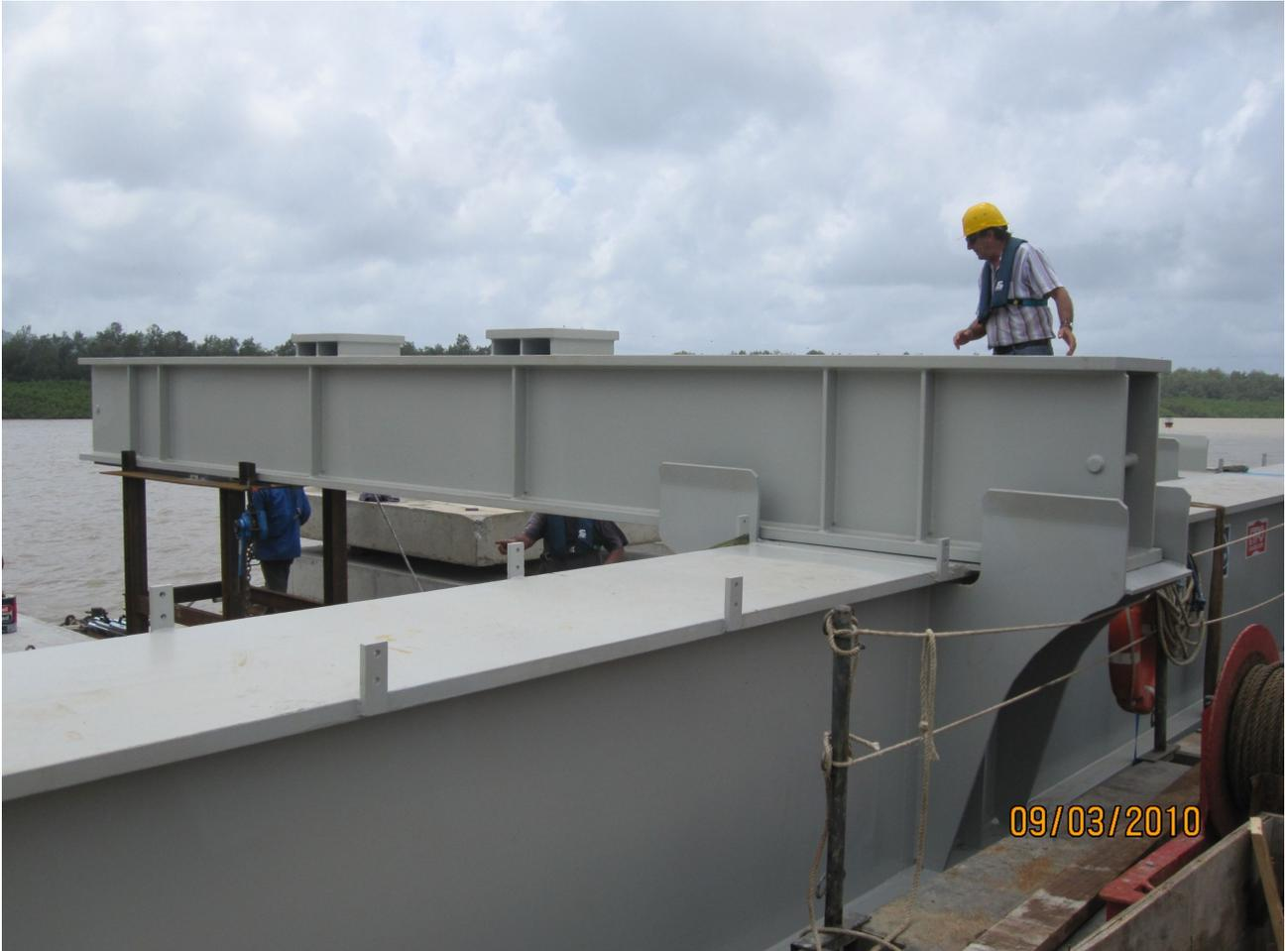
Le ponton est alors remorqué sous le pont au niveau de la pile 13 et les poutres longitudinales sont positionnées au dessus des pieux des quadripodes.
