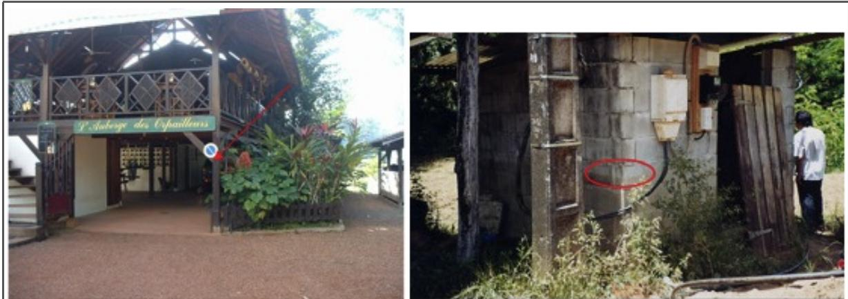
Illustration 14: Laisses de crue de mai 2000 à Roura (1.60 m au niveau du restaurant) et à Cacao (traces visibles sur les parpaings, soit 7.67 m NGG). AZI, Sogreah.
