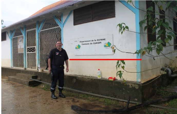
Figure 4 - Niveau atteint par l'eau sur le dispensaire lors de la crue de 2015 (source: Rapport de Préfecture, Reconnaissance de Camopi du 11/05/2015)
