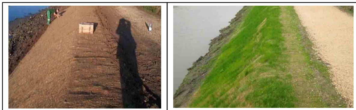
Figure 9 : Exemple de stabilisation de talus en jute de coco en bord de piste – Aqua Terra
