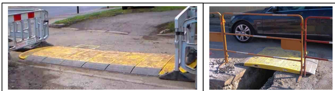
Figure 5 : Exemples de plaques de franchissement temporaire utilisées en traversée de tranchées
