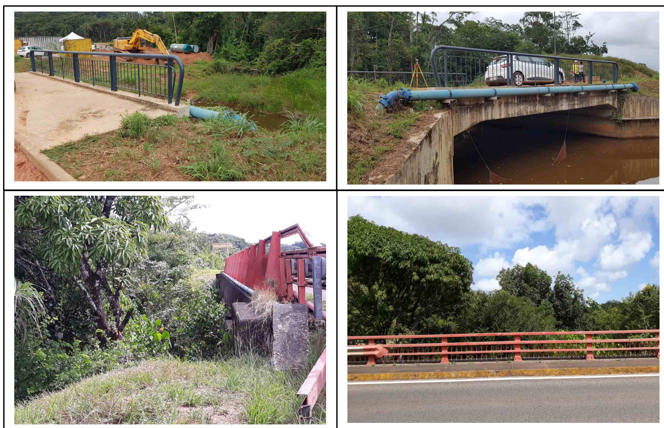
Figure 14 : Passage en support sur tablier de pont (opération Crique Anguille) et tablier du pont Crique Fouillée
