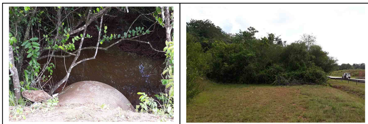
Figure 13 : Accotement et passage busé dans le secteur du centre pénitentiaire
