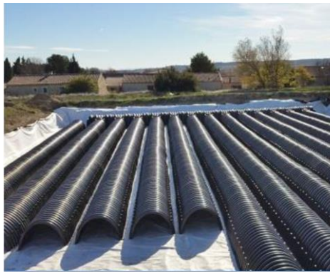
Figure 16 : Extrait de la fiche technique du bassin enterré ELUVIO 10
