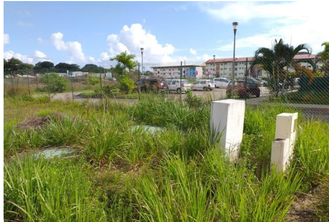
Figure 32 : Poste de refoulement de la résidence kwata 19
