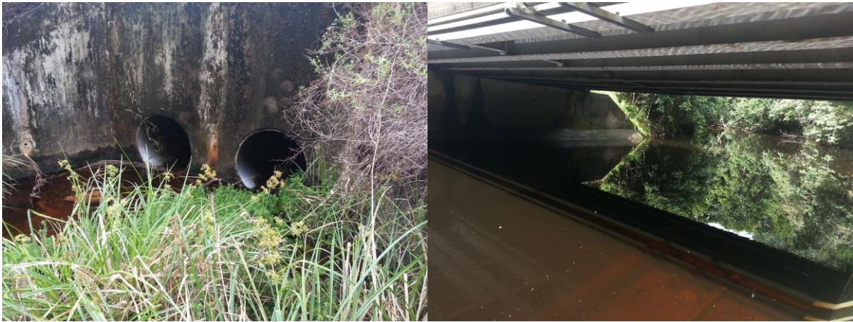
Illustration 14 : Exemples d'ouvrages de franchissement de cours d'eau ne permettant pas le transit de la faune.
