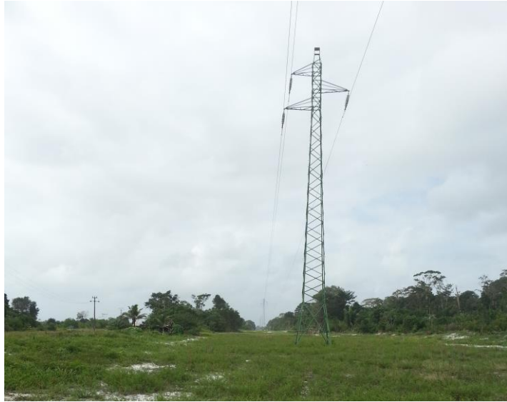
Illustration 4 : Ligne haute tension le long de la RN1 au niveau du carrefour avec la CD8
