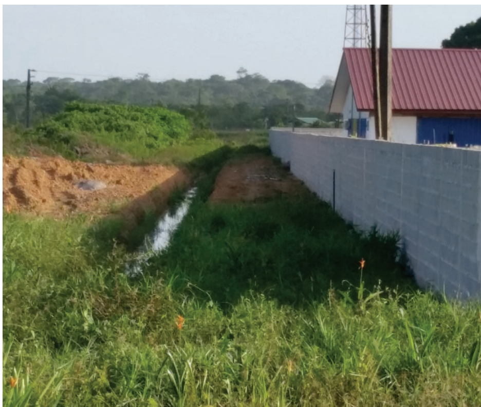
Mise en place de clôtures et de murs d'enceinte, artificialisation de la gestion des eaux de surfaces.
