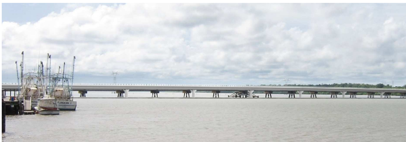
Nouveau pont (vue depuis le port du Larivot)
