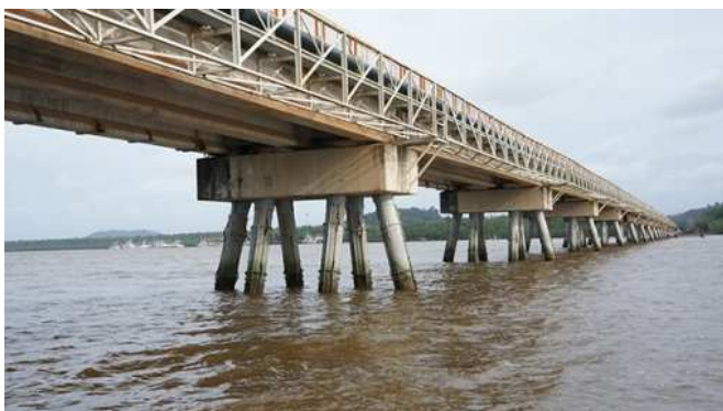
Pont du Larivot - Les piles
