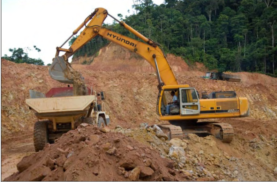
1) Extraction et transport de la saprolite minéralisée
