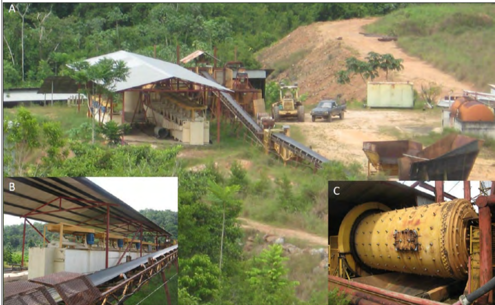
3) A) Vue d'ensemble de l'usine, B) Unité de flottation, C) Broyeur à boulets
