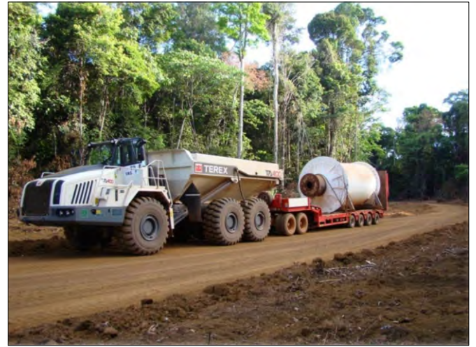
Réfection de la piste et transport par porte-char d'un broyeur à boulets de plus de 20 tonnes
