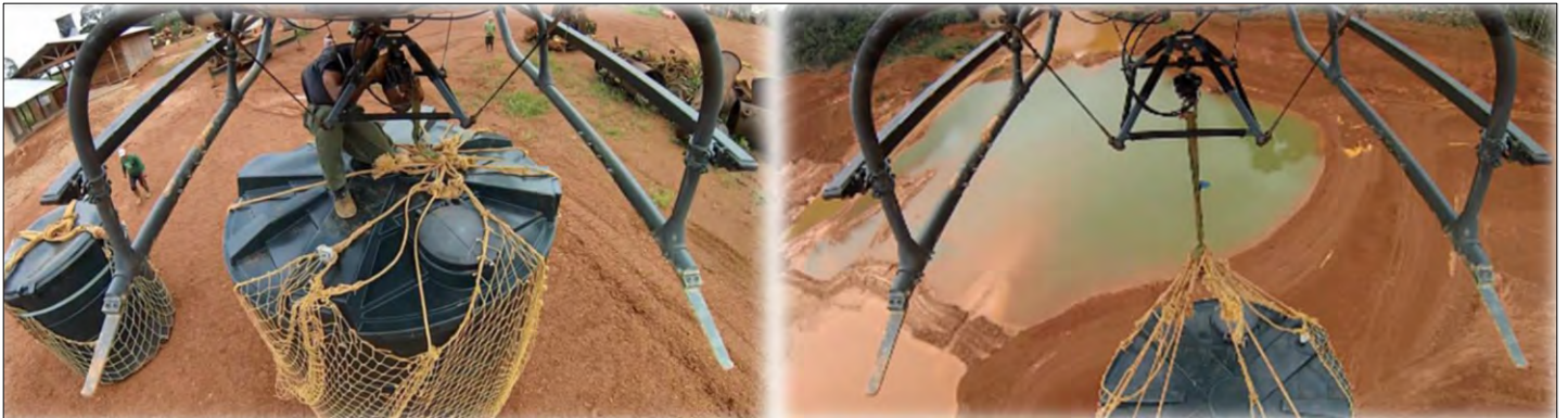
Transport des citernes doubles parois (vides) sur site isolé en hélicoptère
