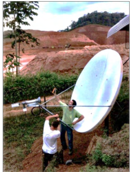
Installation de l'antenne bande C sur le site par GUYACOM en avril 2014
