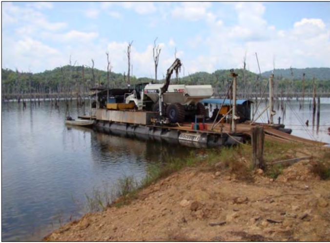
Fabrication en interne d'une barge pouvant transporter plus de 40 tonnes de matériel
