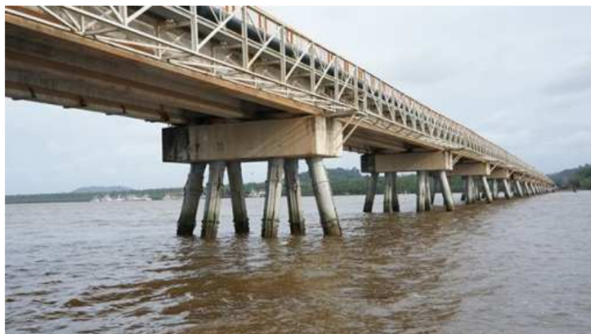
Pont du Larivot – Les piles du pont actuel
