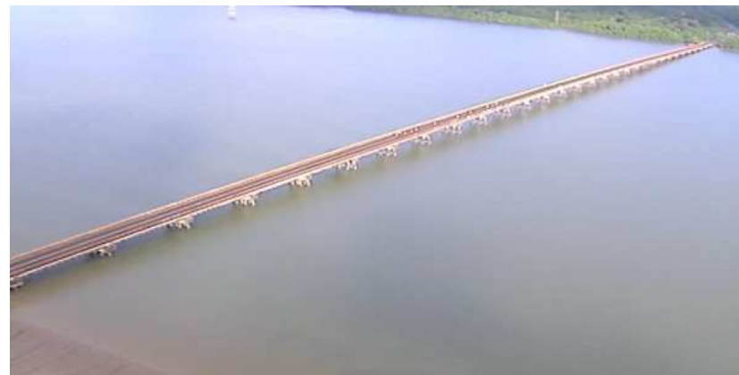
Pont du Larivot – Vue aérienne du pont actuel
