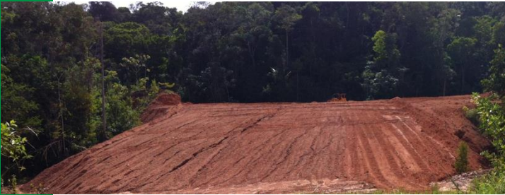
> Verse à stérile enherbée sur la mine d'Espérance. A gauche, état après terrassement. A droite, état après enherbement
