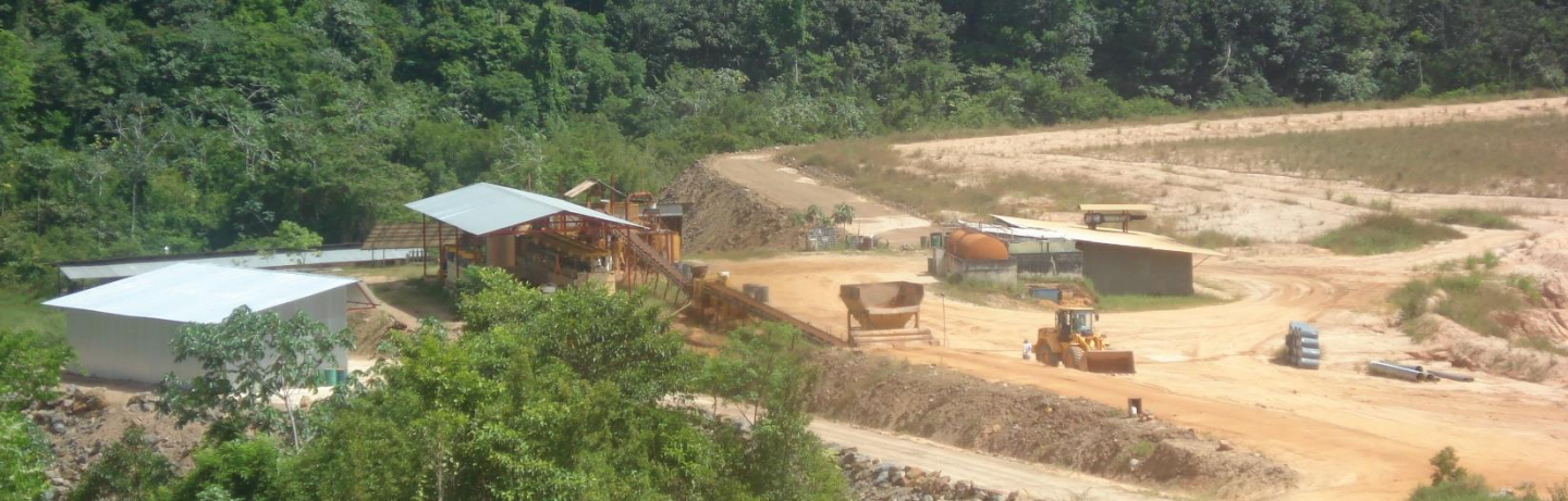
> Usine et atelier de la mine d'Espérance
