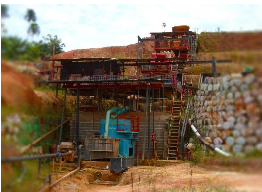
> Usine de broyage/concassage du minerai primaire, Espérance
