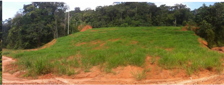
> Verse à stérile enherbée sur la mine d'Espérance. A gauche, état après terrassement. A droite, état après enherbement
