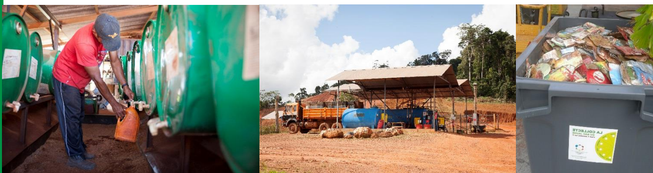
> De gauche à droite : stockage d'huiles sur rétention, citernes de gasoil à double paroi, conserves alimentaires compressées et recyclées – Mine de Saint-Elie
