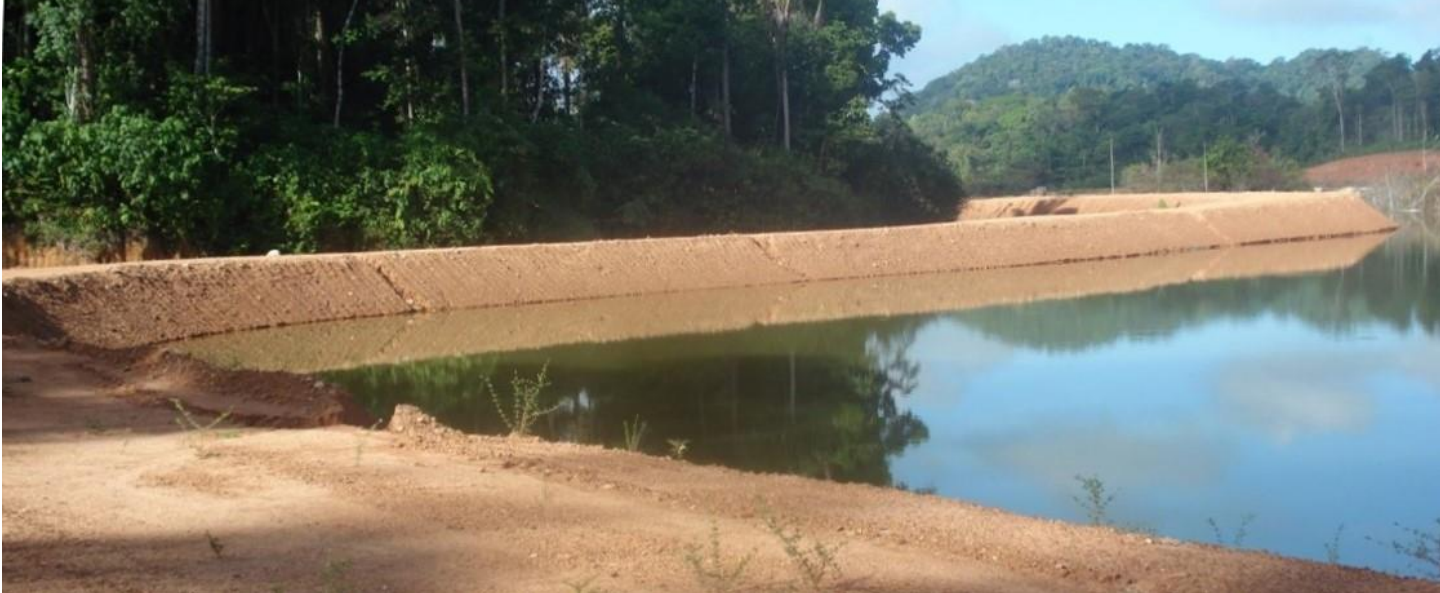
> Digue et bassin sur le site d'Espérance
