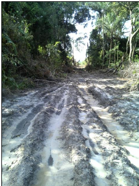
Figure 8 : Forêt haute sur sol sableux
