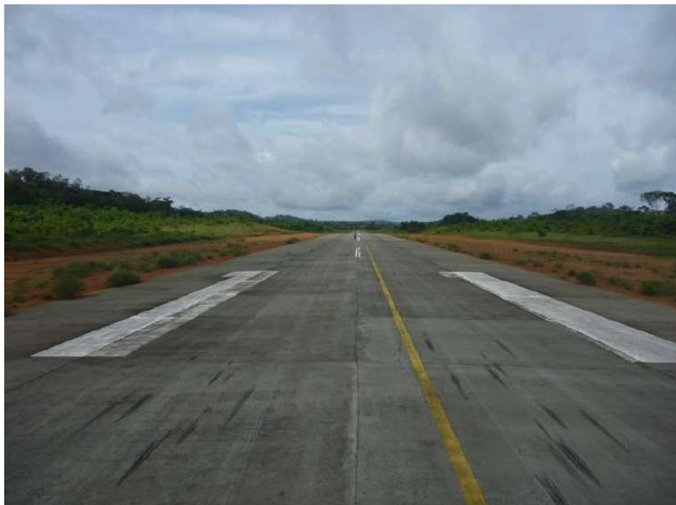
Vue depuis l'extrémité Ouest de la piste vers l'Est
