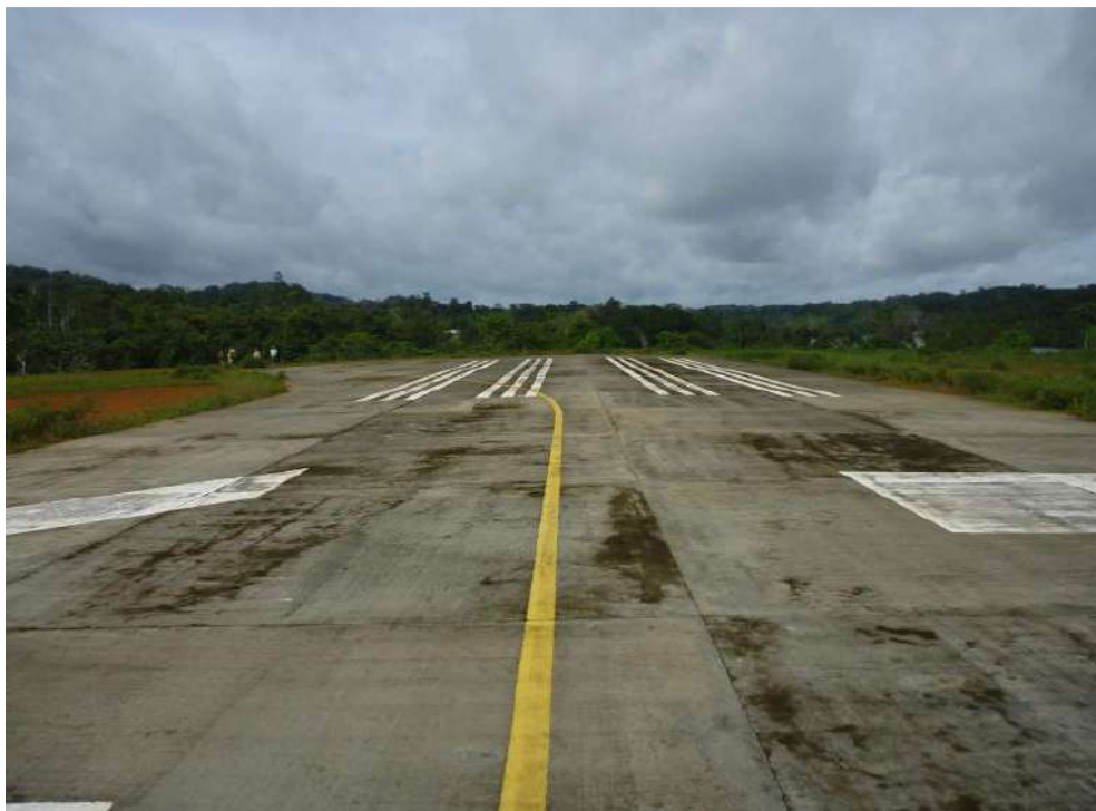
Vues de l'extrémité Est de la piste
