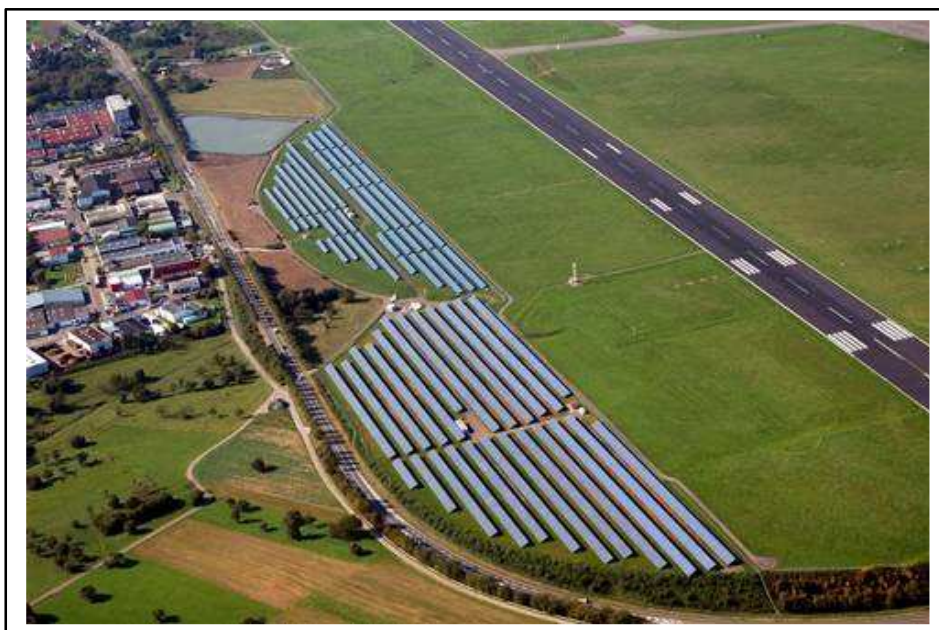
Figure 77 : Ferme solaire de 4 MWc aéroport de Saarbrücken Ensheim - www.photovoltaique.info.com
