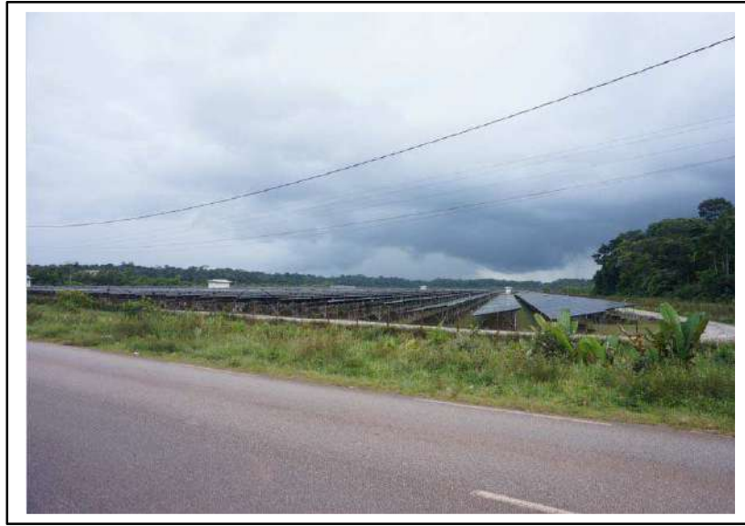
Figure 76 : Centrale solaire du Tour de l'Île dans des paysages similaires en bordure de RD6
