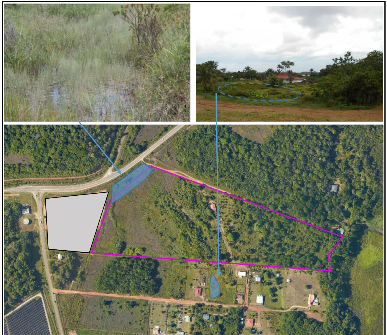
Figure 33 : Zone inondée en bordure de RN2 et thalweg en amont (zones de rétention)
