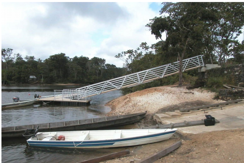
Ouvrages sur le domaine public fluvial.
