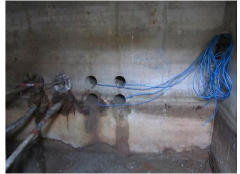
Figure 2 : Vue intérieure d'une chambre-plage (Orange Marine)
