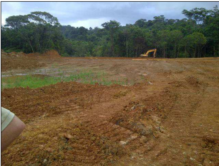
Figure 32 : Vue des chantiers réhabilités, au nord du lieu-dit « Camp Léonce », C01/89, au 28/08/2013
