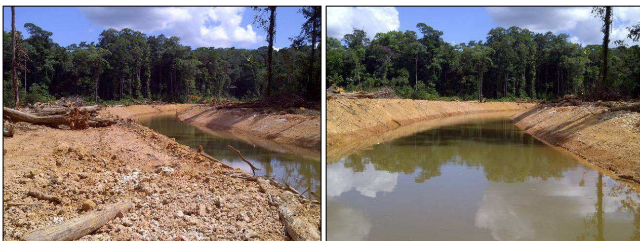
Figure 25 : Vue de la crique Boulanger re-profilée, concession C01/89 en amont de l'AEX n°03/2012, 24/10/2012
