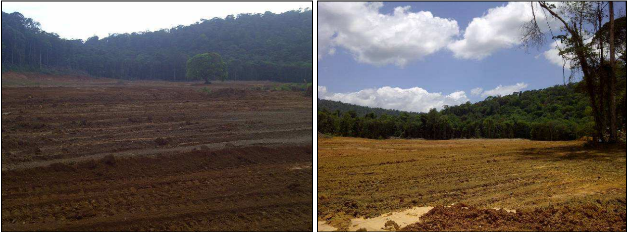
Figure 33 : Vue des chantiers réhabilités, lieu-dit « Camp Léonce », C01/89, à environ 100 m en aval de la RN2, au 18/09/2013
