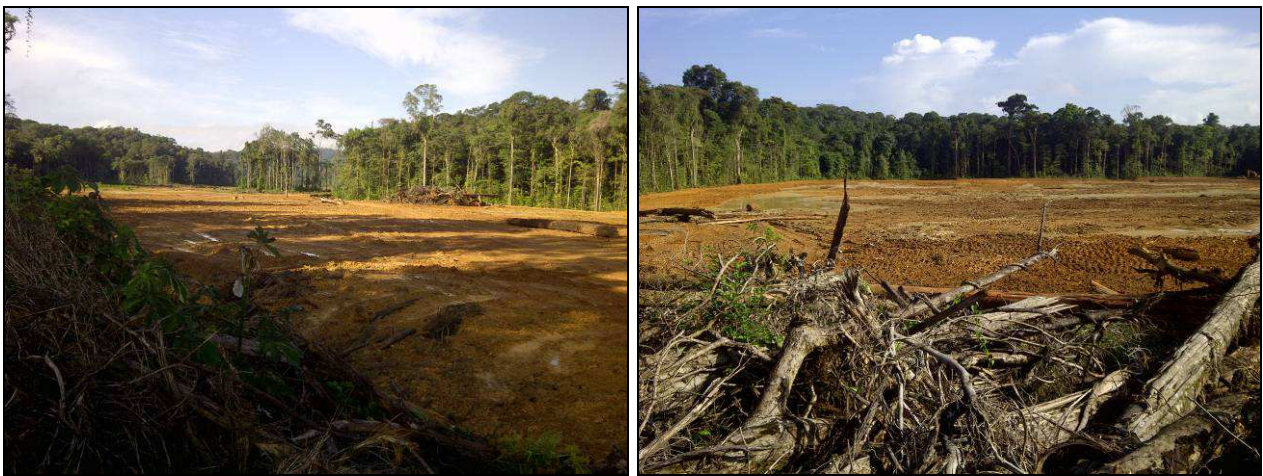
Figure 31 : Vue des chantiers réhabilités avant étalement des andains, aval « Aval-Léonce », C01/89 au 02/05/2013
