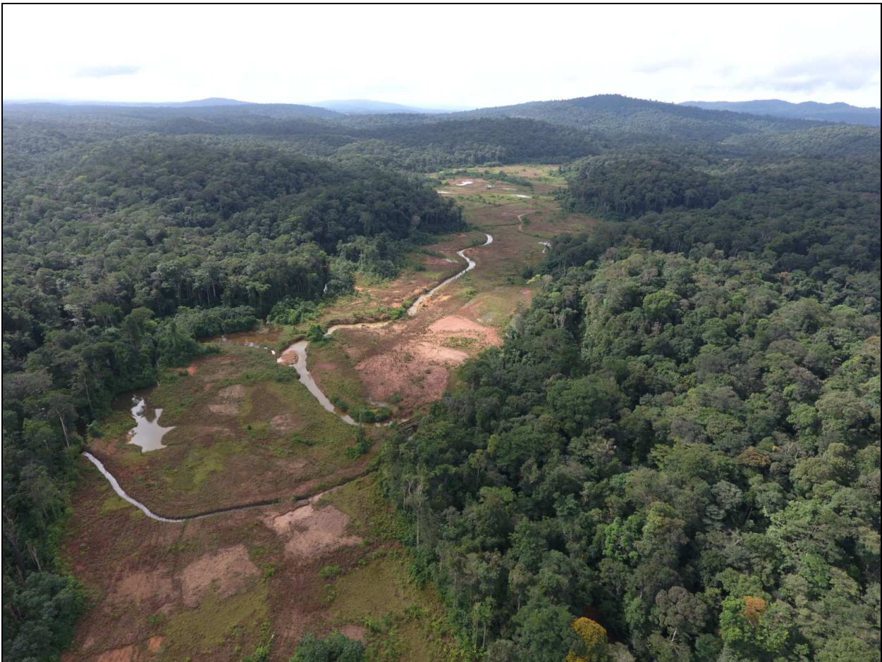
Figure 23 : Vue aérienne du secteur Aval Léonce en 2017 (zone avale en premier plan), source SOLICAZ
