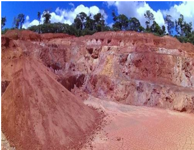
Photo 4 et 5 : Reprofilage de la colline Virgile Ouest. Ce vaste amphithéâtre à 5 niveaux sera ramené à 3 niveaux de terrasses, avec comblement des ravines puis ouverture de fosses de plantations. Les talus de déblais seront traités avec des bourrelets ré- enherbés selon méthode testée sur la digue Ovide.
