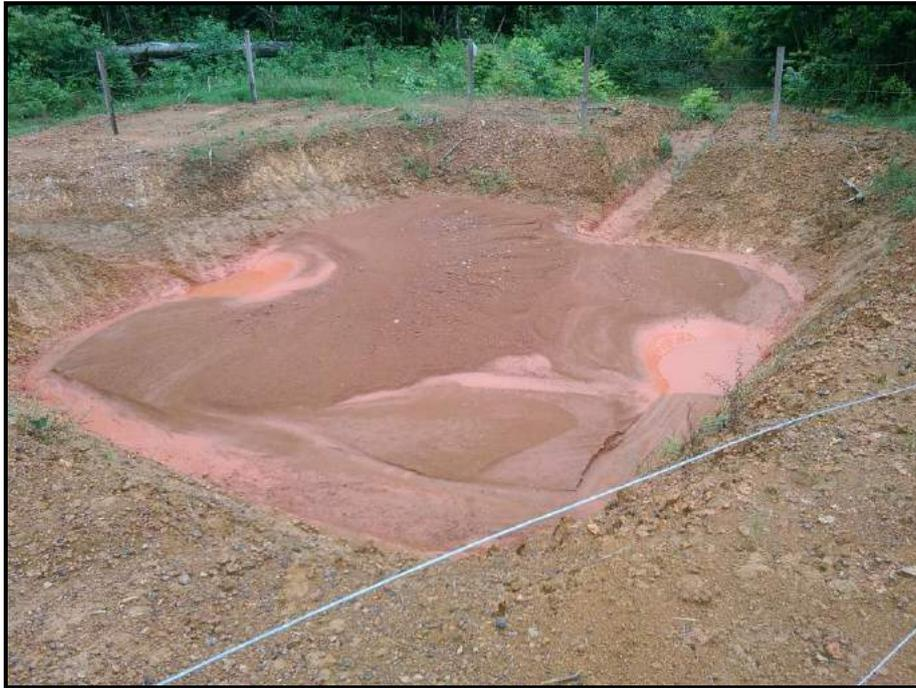
**Figure 43 : Bassin de décantation mis en place au niveau du morne en cours d'exploitation**
