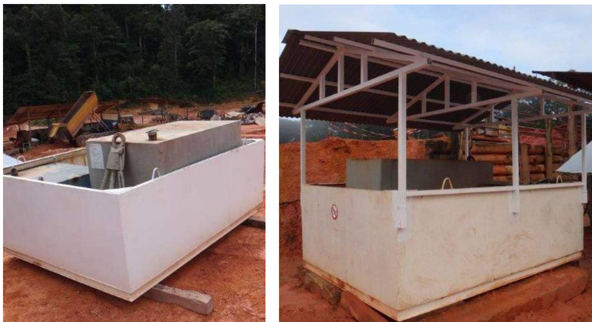
Figure 55 : Cuves de 1000 et 2000 L dans bacs rétention avec toit amovible
