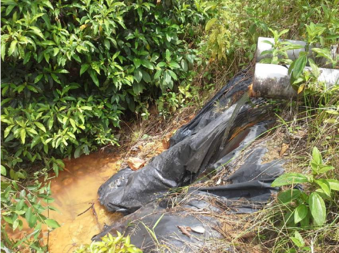
Figure 18 : Surverse 1 des eaux de ruissellement sur talus protégé
