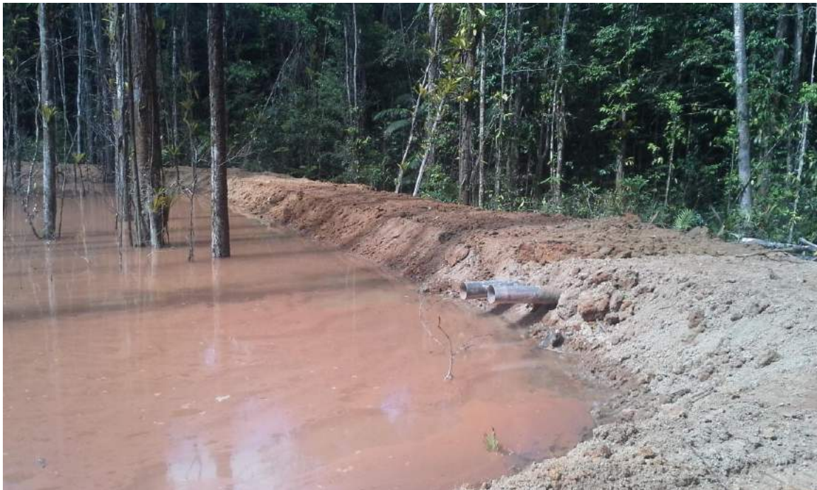
Figure 18b : Surverse 2 en cours de réaménagement
