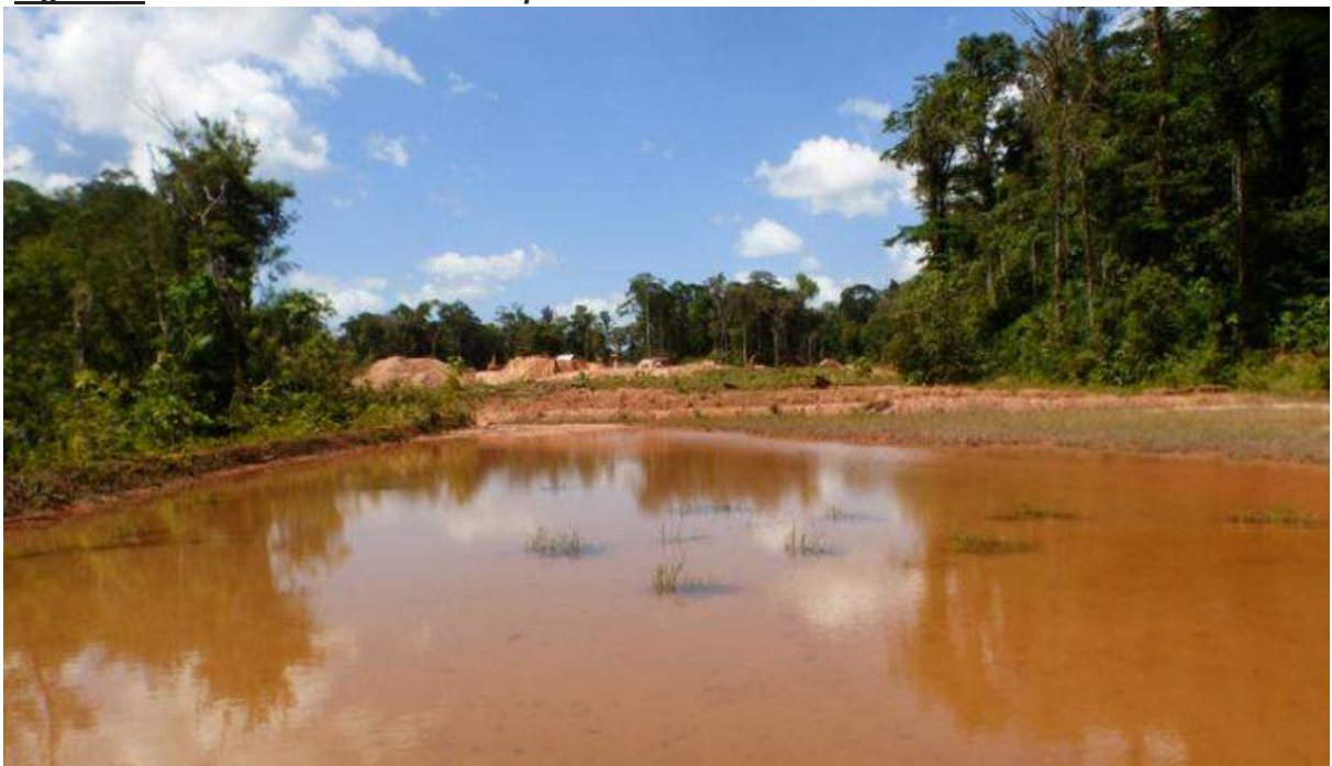
Figure 34 : Bassin de décantation et partie réhabilitée
