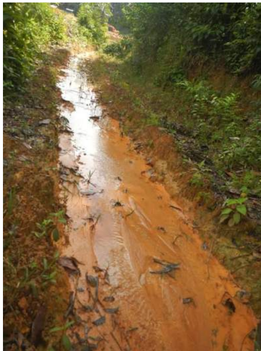
Figure 28: Criquot dans son canal de dérivation le long du relief bordant la mine.
