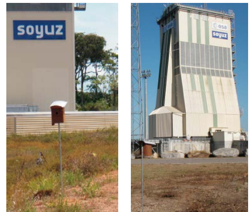
Figure 4 : Installation de nichoirs sur Soyuz.
