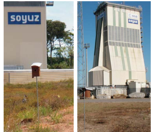
Figure 4 : Installation de nichoirs sur Soyouz.
