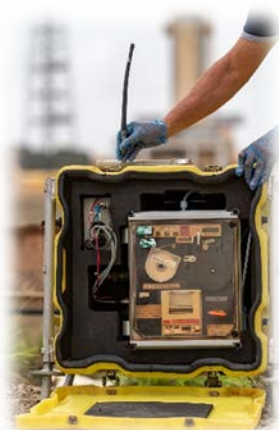
Figure 5 : SPM en cours de mise en place
