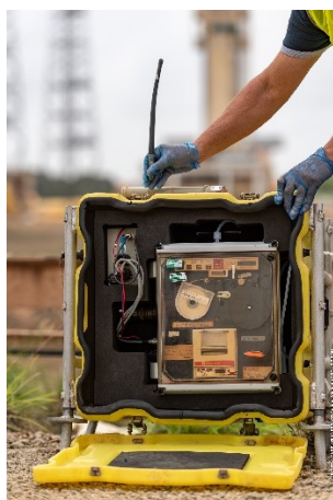
Figure 5 : SPM en cours de mise en place
