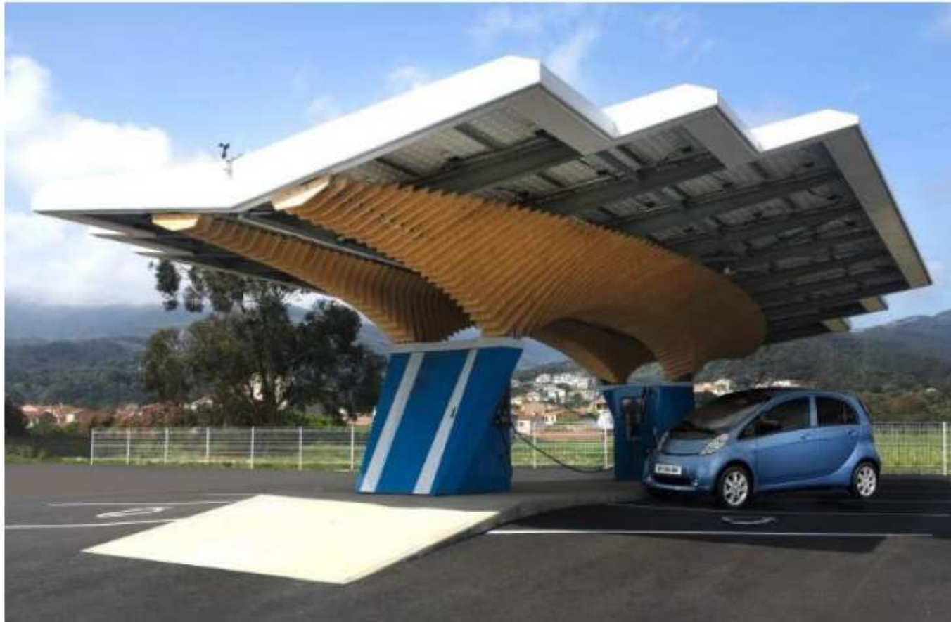
Figure 96 : Station Driveco en Corse : recharge VE à énergie renouvelable avec appoint réseau
