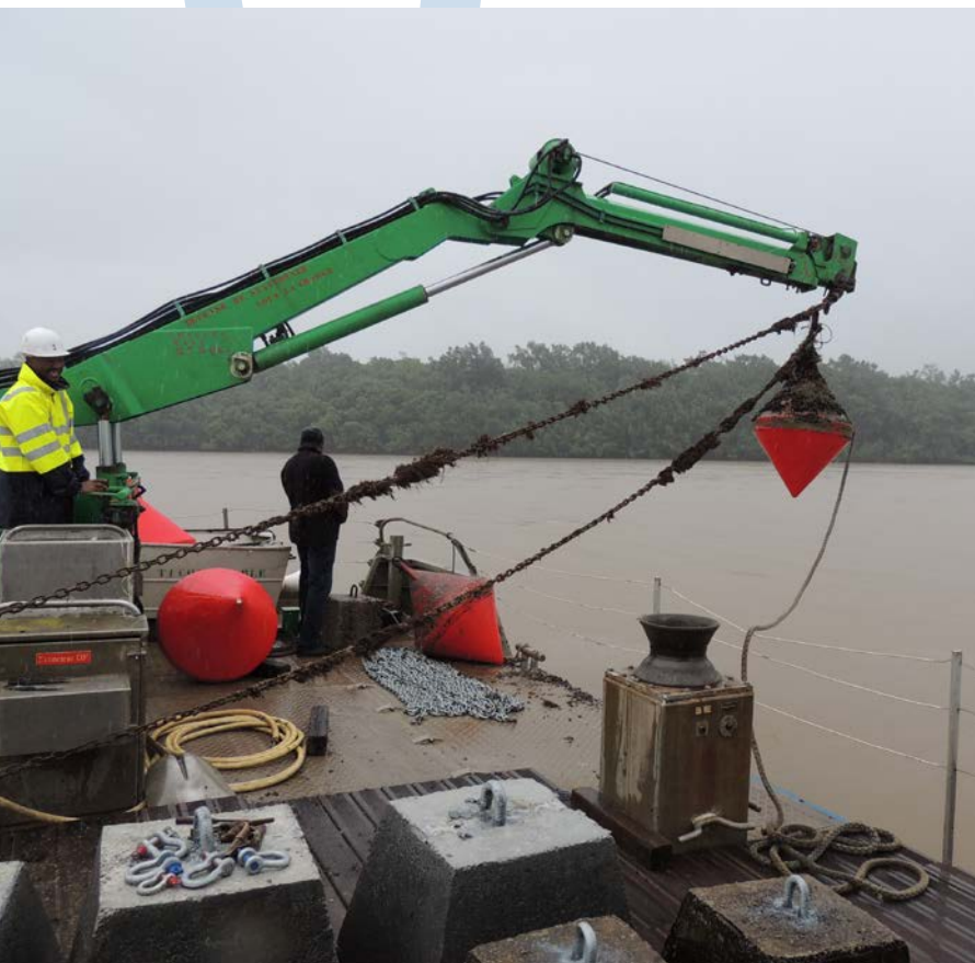
Remplacement des corps morts pour les balises situées sur le Mahury
