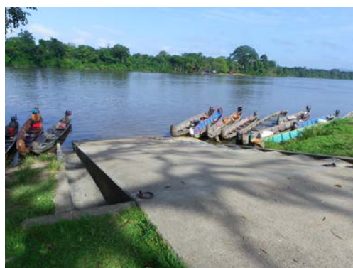
Cale en béton devant le carbet communal - Grand Santi
