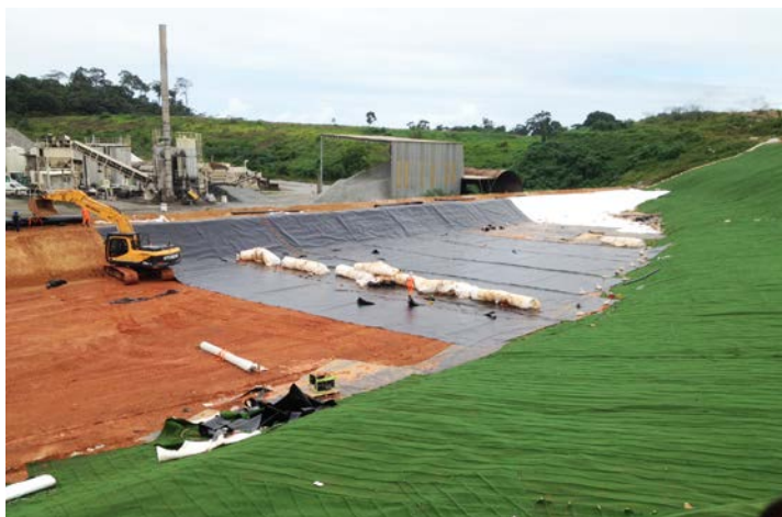
Mise en place d'un nouveau casier à la décharge des maringouins
