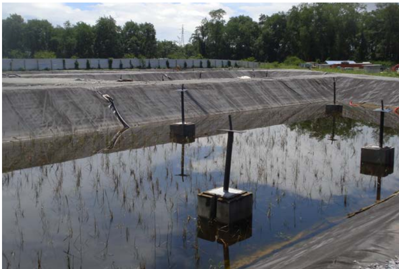
Station d'épuration Leblond - Cayenne
