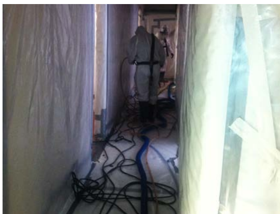
Travaux de désamiantage du bâtiment rue Mentel
