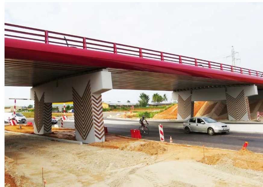
Chantier de Balata
