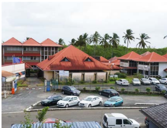
DEAL de Guyane , site du Vieux-Port
