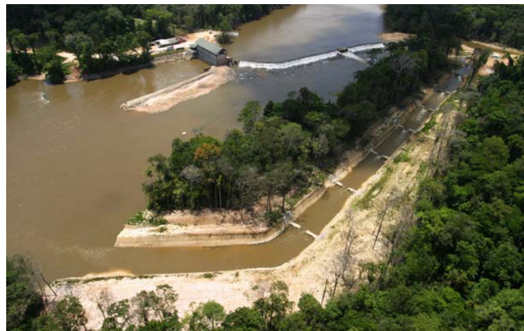
Centrale hydroélectrique de saut Maman Valentin - Mana / © ONF
