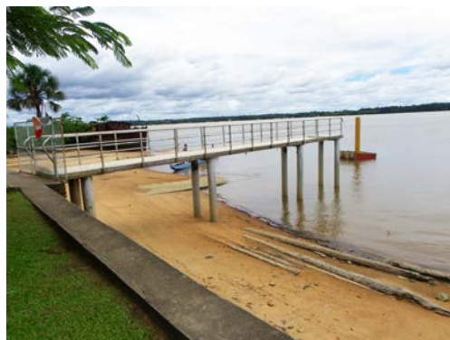
Ponton en cours de réalisation - Saint-Laurent du Maroni
