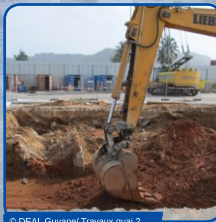
© DEAL Guyane/ Travaux quai 2
