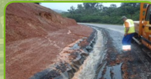
© DEAL Guyane/imperméabilisation avec une géomembrane sur la RN 2
