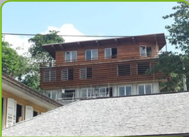
© DEAL Guyane/opération PAOLA- un bâtiment exemplaire en matière de consommation énergétique. (Cayenne), coût global de 350K€
