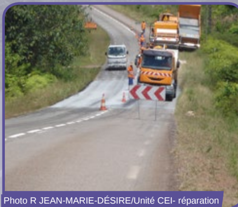
Photo R JEAN-MARIE-DÉSIRE/Unité CEI- réparation de la RN2
