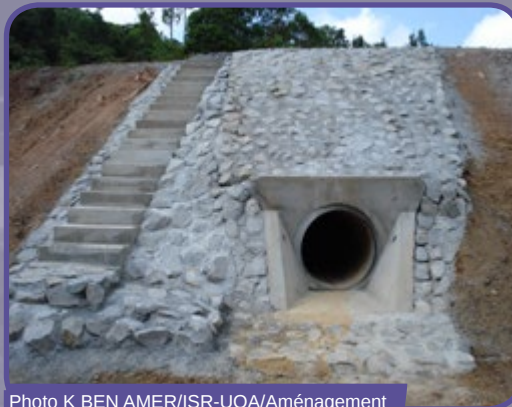
Photo K BEN AMER/ISR-UOA/Aménagement d'escalier de visite
