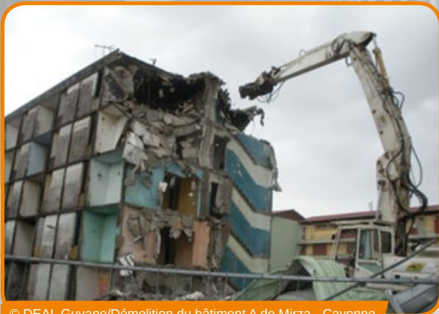
© DEAL Guyane/Démolition du bâtiment A de Mirza - Cayenne
