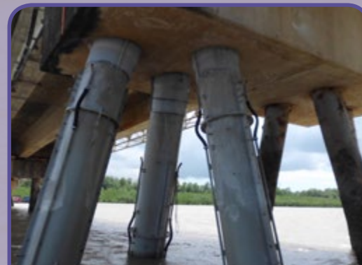
Photo K BEN AMER/ISR-UOA - Confortement des pieux du pont du Larivot
