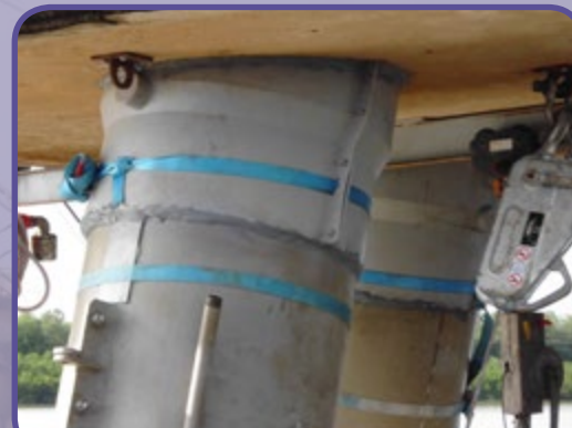
Photo K BEN AMER/ISR-UOA - Coque PRV pour assurer la finition virole/chevêtre du pont du Larivot
