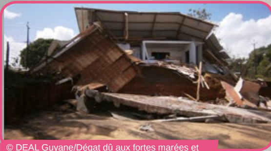
© DEAL Guyane/Dégât dû aux fortes marées et montées d'eau/route des plage -rémire-Montjoly
