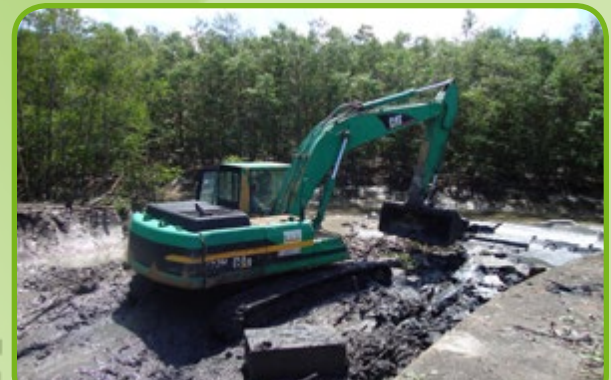
© DEAL Guyane/Nettoyage des abords - Canal Laussat, Cayenne
