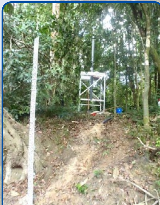
© DEAL Guyane/Installation de la station hydrométrique du Kourou [août 2012]
