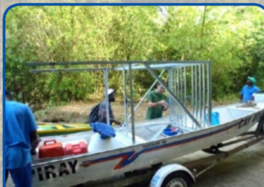
© DEAL Guyane/Installation de la station hydrométrique du Kourou [août 2012]
