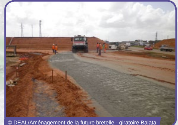
© DEAL/Aménagement de la future bretelle - giratoire Balata -Matoury
