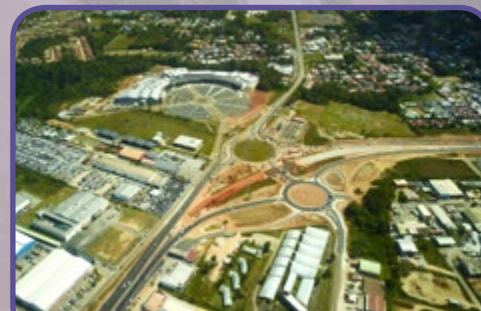
Photo © Effage - Travaux de l'échangeur de BALATA
