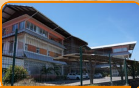
Photo L VERNET/DEAL Guyane - site de Buzaré
