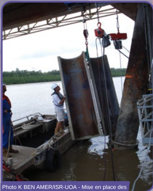
Photo K BEN AMER/ISR-UOA - Mise en place des viroles métalliques du pont du Larivot
