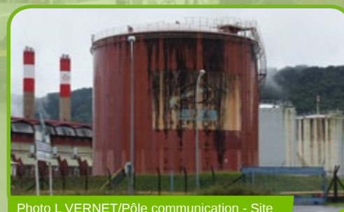
Photo L VERNET/Pôle communication - Site Sara EDF -Dégrad des Cannes
