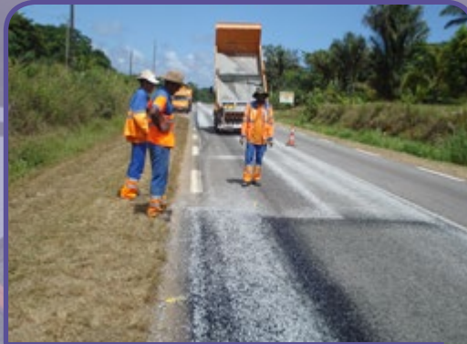
Photo R JEAN-MARIE-DÉSIRE/Unité CEI-Réparation sur la RN1
