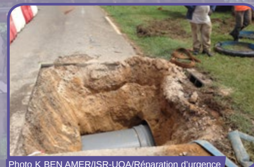
Photo K BEN AMER/ISR-UOA/Réparation d'urgence suite à inspection la RN1
