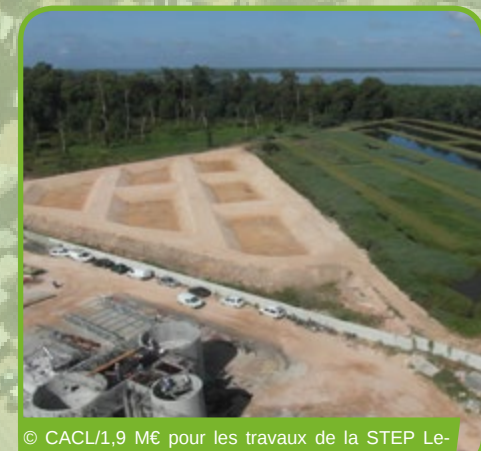
© CACL/1,9 M€ pour les travaux de la STEP Le-blond (traitement des boues) à Cayenne
