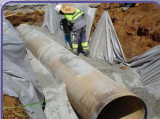
Photo K BEN AMER/ISR-UOA/remplacement du Buse Métallique sur la RN1
