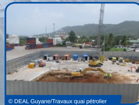
© DEAL Guyane/Travaux quai pétrolier
