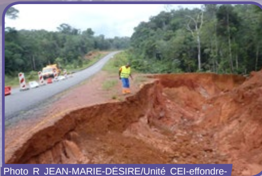
Photo R JEAN-MARIE-DÉSIRE/Unité CEI-effondrement talus RN2
