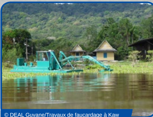
© DEAL Guyane/Travaux de faucardage à Kaw
