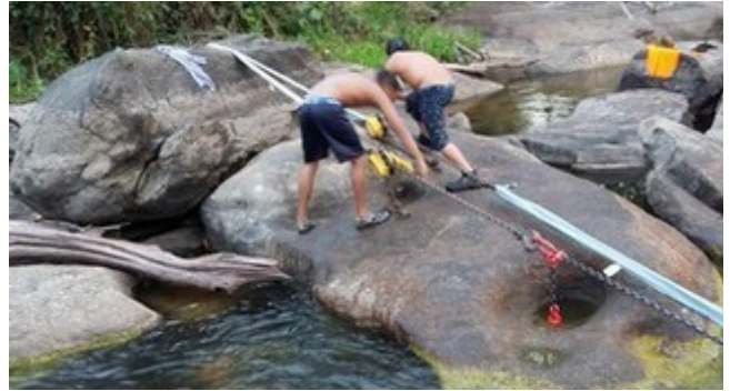
Méthode utilisée pour déplacer les blocs rocheux
