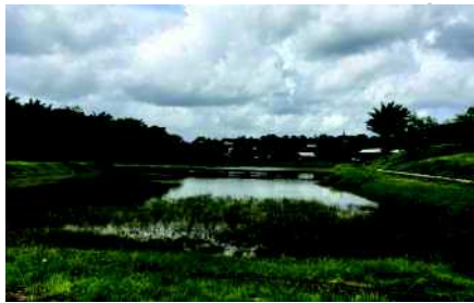
Bassin de rétention structurant un parc Balata- Matoury
