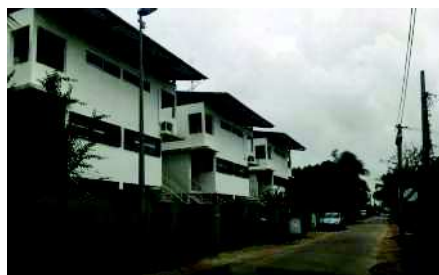
Constructions sur pilotis- Rémire-Montjoly
