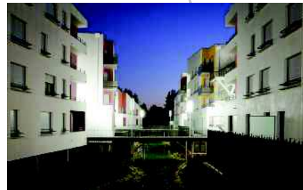
Logements sociaux- L'Aumône- Saint-Ouen
