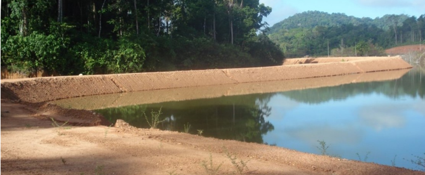
> Digue et bassin sur le site d'Espérance
