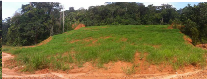
> Verses à stérile enherbée sur la mine Espérance. A gauche, état après terrassement. A droite, état après enherbement
