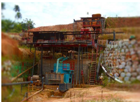
> Ancienne usine de broyage/concassage du minerai primaire, Espérance
