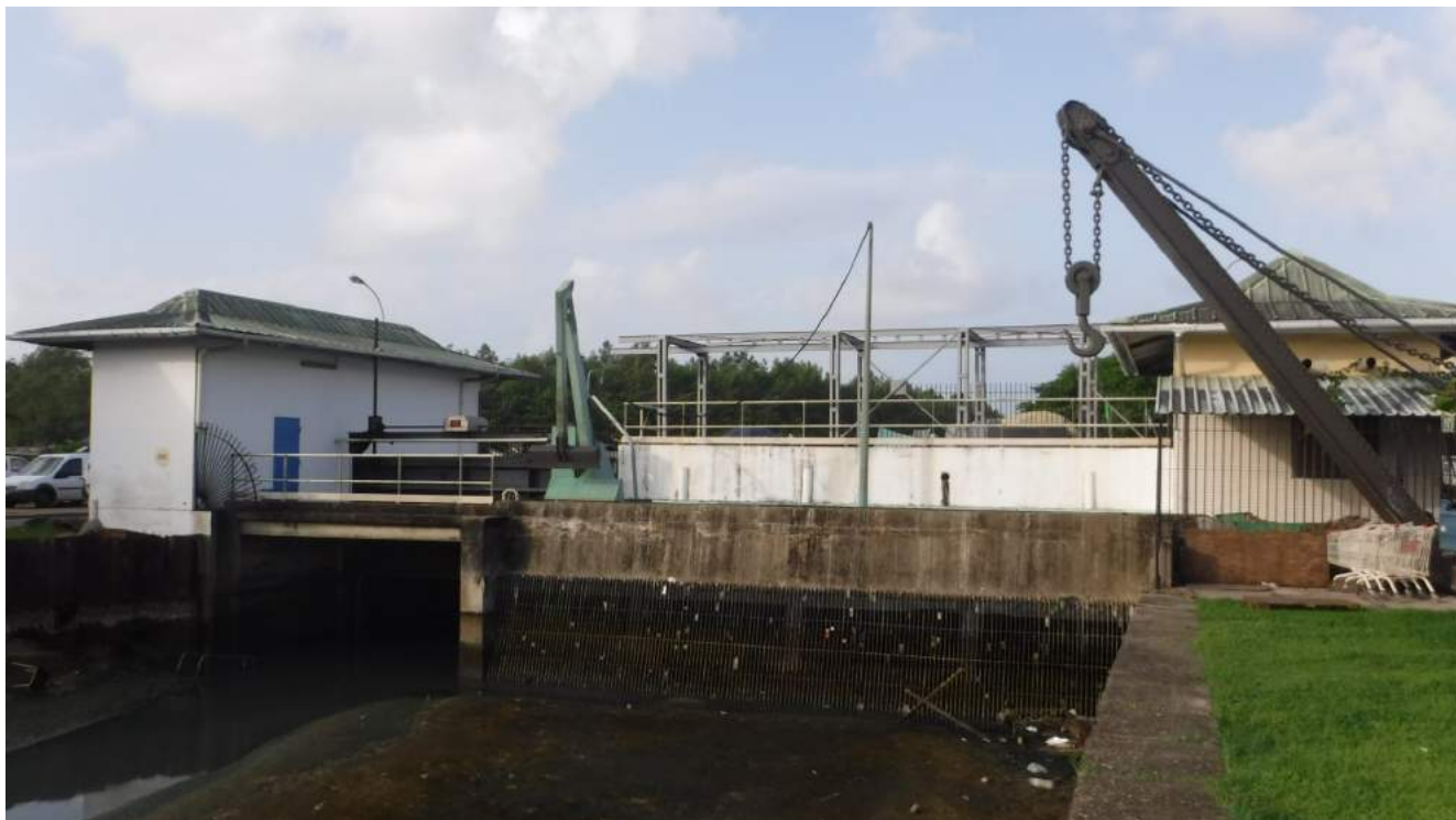
Illustration 12: photographie de la vanne écluse du canal Laussat
