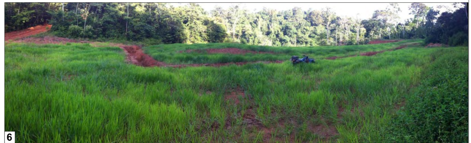
Premiers résultats obtenus sur la deuxième verse retalutée et ensemencée : 4) Etat après terrassement, 5) Etat après ensemencement, vue sur une pente, 6) Etat après ensemencement, vue sur le plateau
