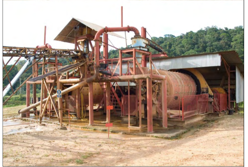
2) Usine de lavage, concassage, broyage et concentration gravimétrique
