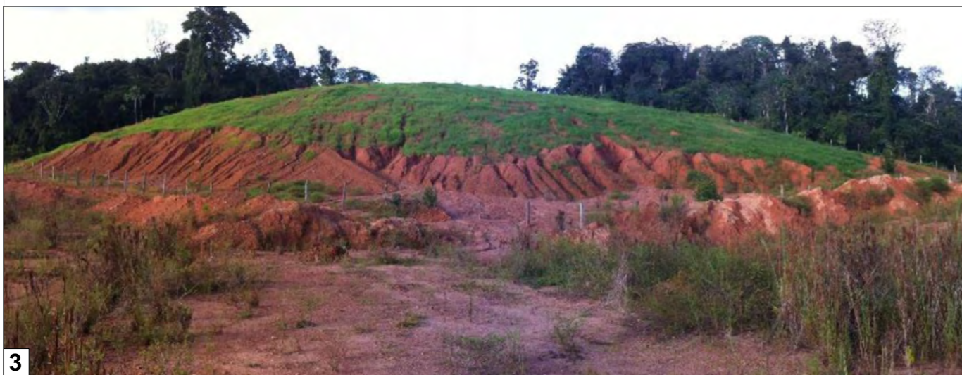
Premiers résultats obtenus sur la première verse retalutée et ensemencée : 1) Etat initial de la verse, 2) Etat après terrassement, 3) Etat après ensemencement
