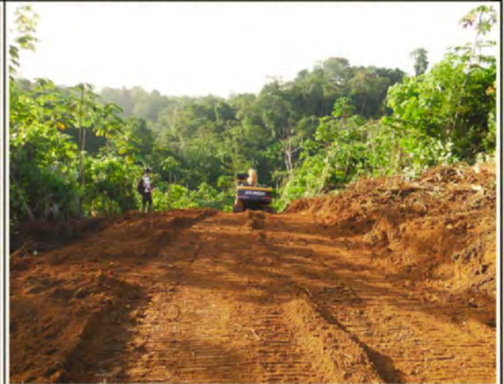
Photo E : Remise en état du site après les travaux
