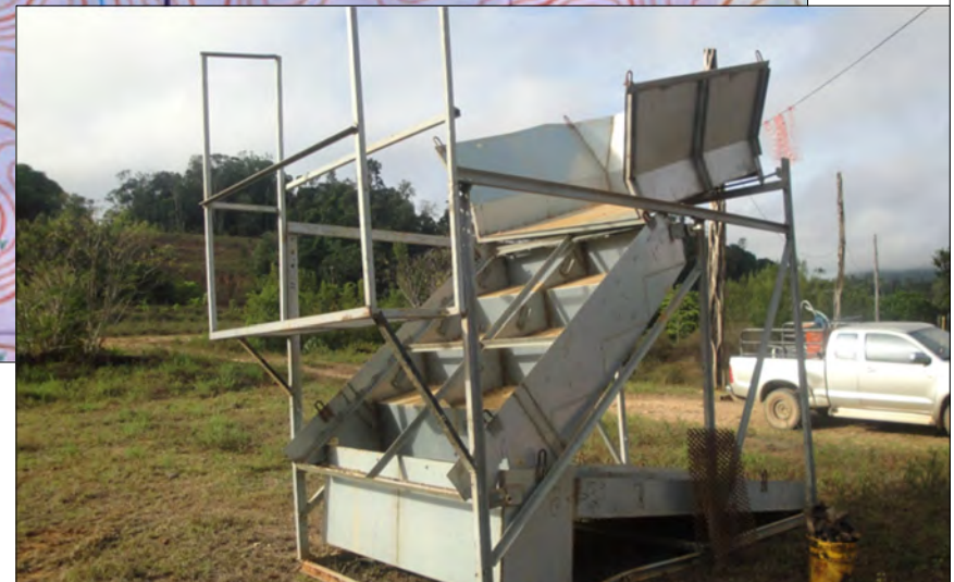
Grille de lavage en cours de construction sur le site d'Espérance
