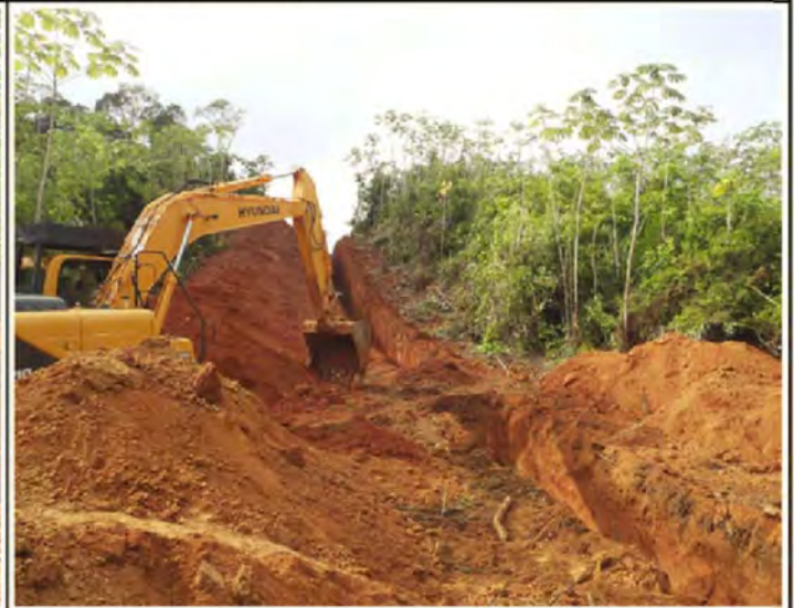
Photo C : Tranchées réalisées dans la zone NE-03.
