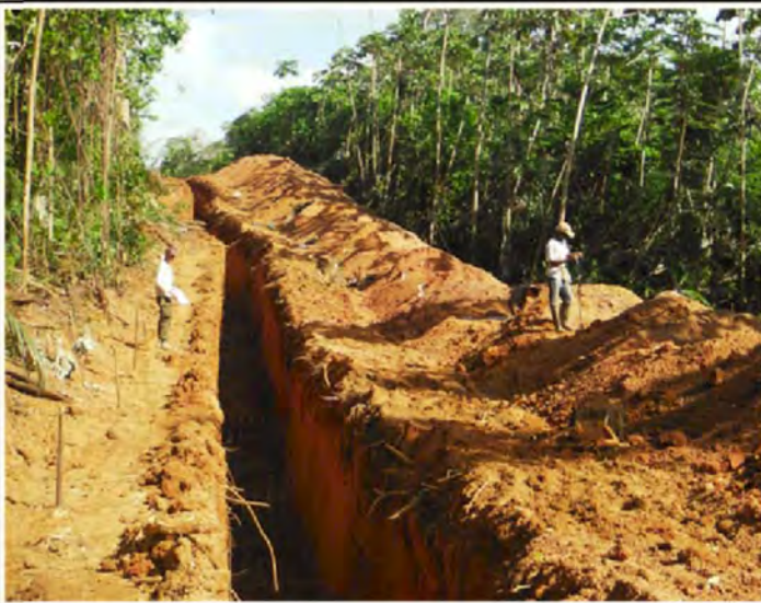
Photo B : Réalisation de tranchées de reconnaissance.
