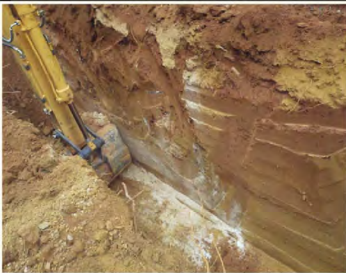
Photo D : Mise en évidence de filons dans les tranchées.
