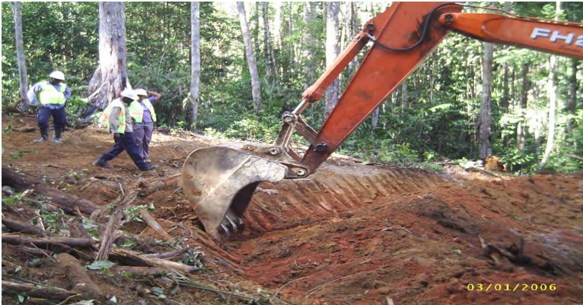
Figure 4: Zone qui a été talutée
