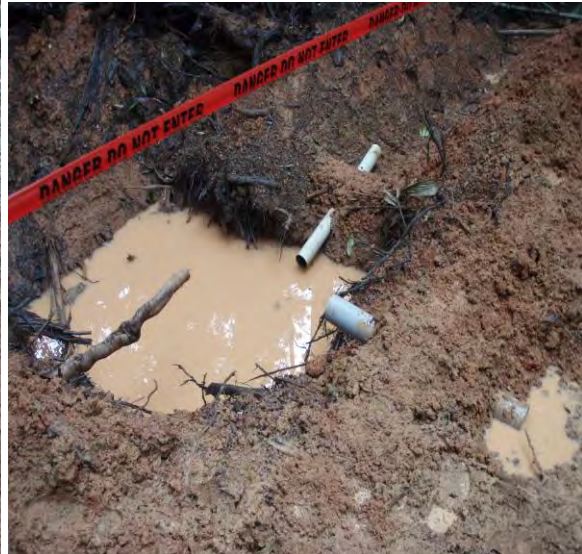
Figure 2. Puisard de liquides de forages avec débordement.
