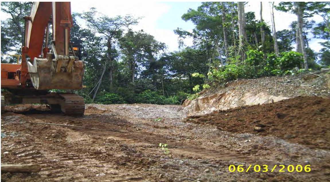
Figure 5: Zone escarpée qui a été remblayée
